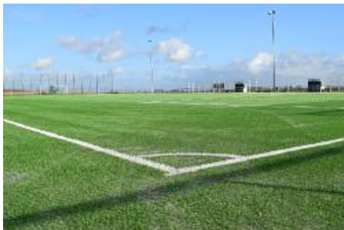
Nach erfolgreicher Renovierung erstrahlt der Kunstrasenplatz im Stadion an der Blayer Straße nun wieder in saftigem Grün.
