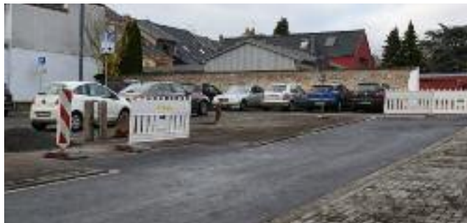
Im Zuge der Umgestaltung des Parkplatzes an der von-Lutzenberger-Straße wurde unter anderem eine neue Ausfahrt angelegt.
