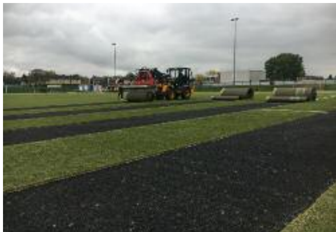
Zum Start der Umbauphase wurde der alte Kunstrasenbelag im Stadion an der Blayer Straße fachgerecht abgetragen.
